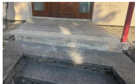
Podest vor der Sanierung mit prov. Antrittsbrett
